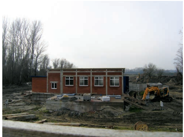
Radovi na gradilištu crpne stanice tijekom posjeta
