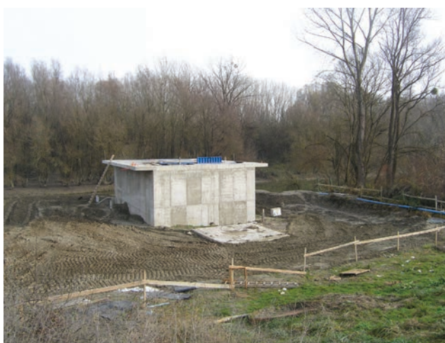
Ulazno-izlazna građevina pokraj Zmajevačkog Dunavca
