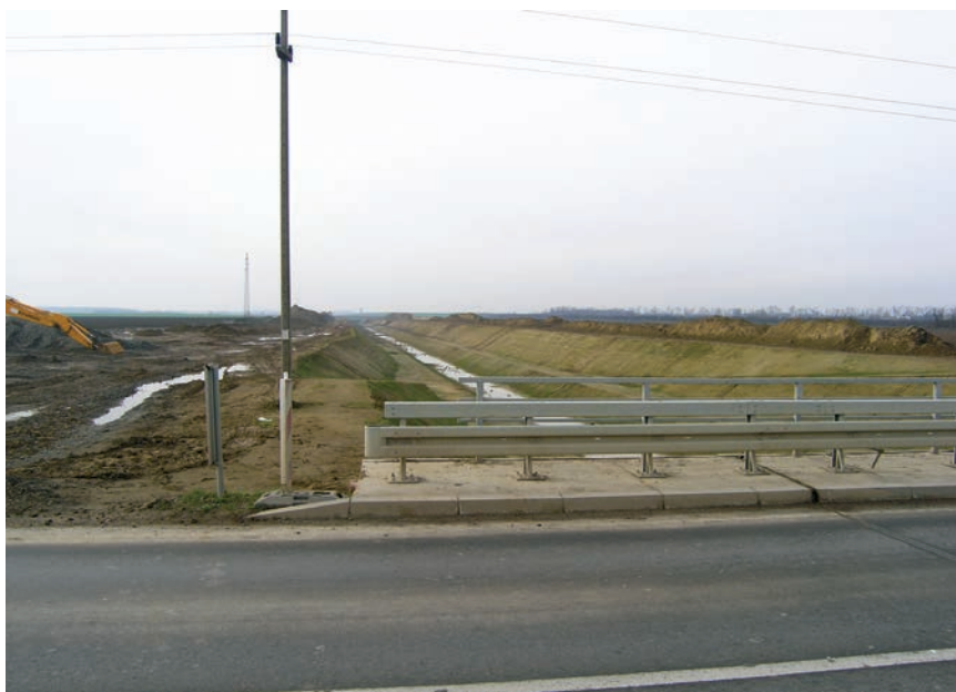
Završni dio kanala sa spojem na kanal Bojana
