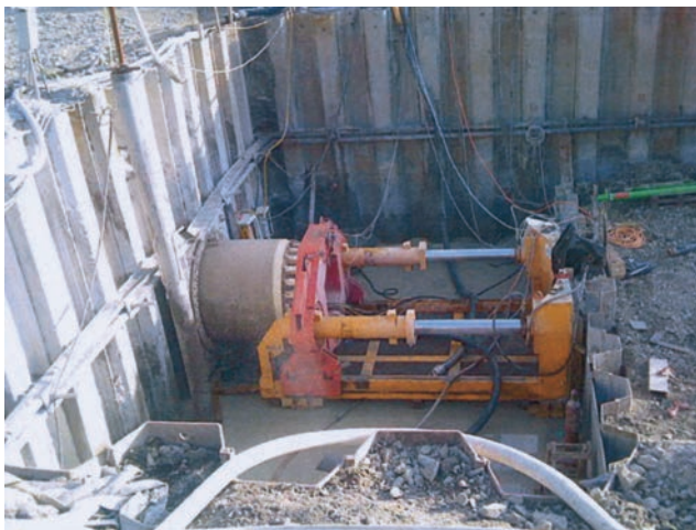
Mikrotuneliranje nasipa Zmajevac – Kopačevo
