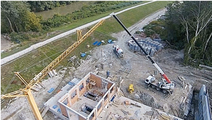
Pogled s dizalice na gradilište crpne stanice
