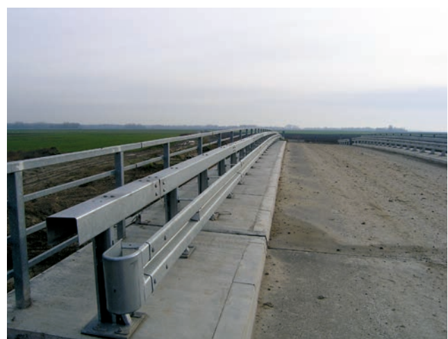
Most Zmajevac preko lateralnog kanala
