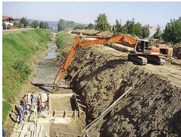
Čišćenje jednog bujičnog kanala
